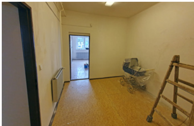
Stav před opravou.
