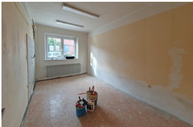
Stav před opravou.
